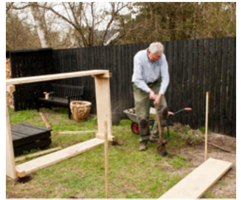
4 Rammen er færdigmonteret med kraftige skruer, og nu graves de fire huller, som hjørnepælene skal placeres i
