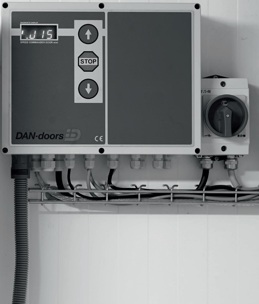
Der SCD-Steuerkasten ist bedienerfreundlich und bietet eine Reihe von Parametern, durch deren Einstellung der Betriebsmodus jedem individuellen Kühlraum angepasst werden kann. Die SCD-Steuerung betreibt das Türblatt mittels eines Zahnriemens, wodurch reibungsloses Öffnen und Schließen sichergestellt sind.
