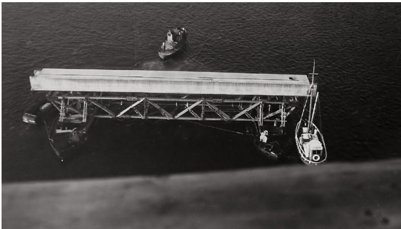
Kassedragerne til rampefagene blev sejlet ud på to sammenbyggede sukkerroepramme.
