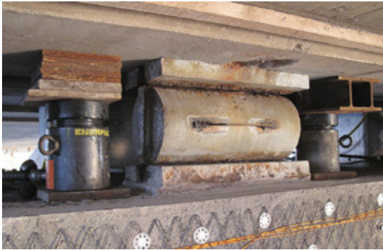
De to donkrafte løfter brodrageren, så det gamle rulleleje kan udskiftes med en moderne konstruktion (øverst).
