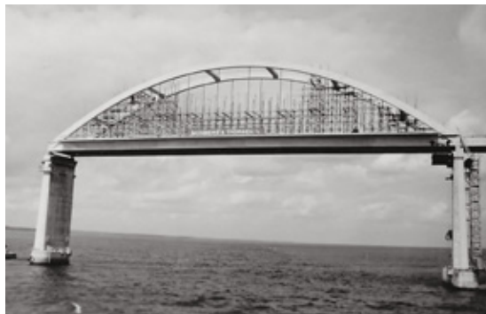
Øverst: Stillads til støbning af dragere, bjælker og kørebanaplader. Nederst: De to imponerende betonbuer blev støbt på stedet.
