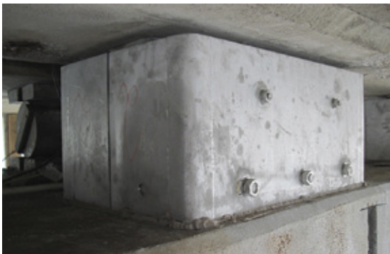
De to donkrafte løfter brodrageren, så det gamle rulleleje kan udskiftes med en moderne konstruktion (øverst).
