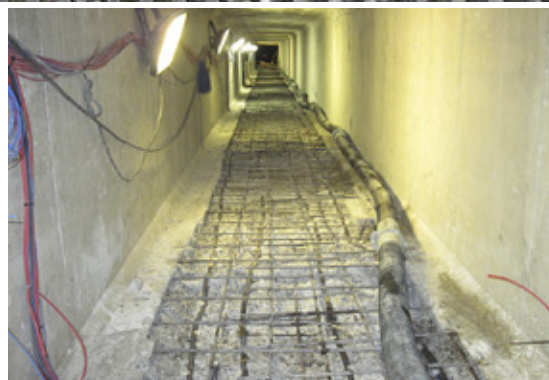
Klar til støbning af ny beton inde i en af brodragerne.
