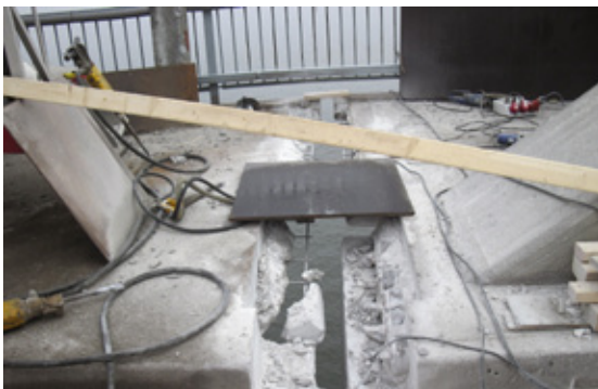
Øverst: Renoveret og forstærket lejeplint. Nederst: Renovering af fuge i fuld gang.
