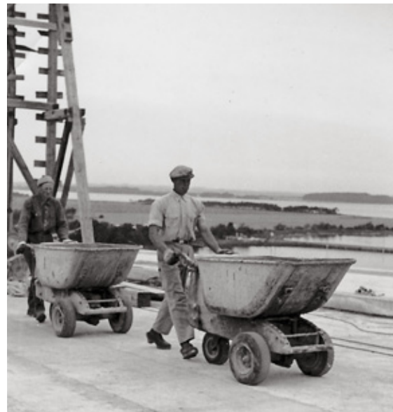
I alt blev der anvendt op mod 15.000 kubikmeter beton til Langelandsbroen - meget transporteret på trillebør.
