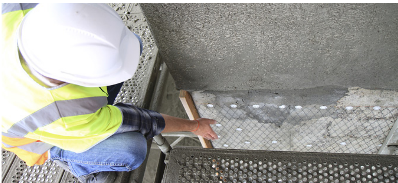
Metalnettet er en del af det anlæg til katodisk beskyttelse, der skal standse korrosion af broens stålarmering.
