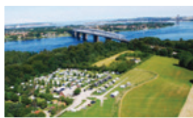
Hindsgavl Camping Søbadvej 10 5500 Middelfart Tel. +45 6441 5542 www.hindsgavl-camping.dk
