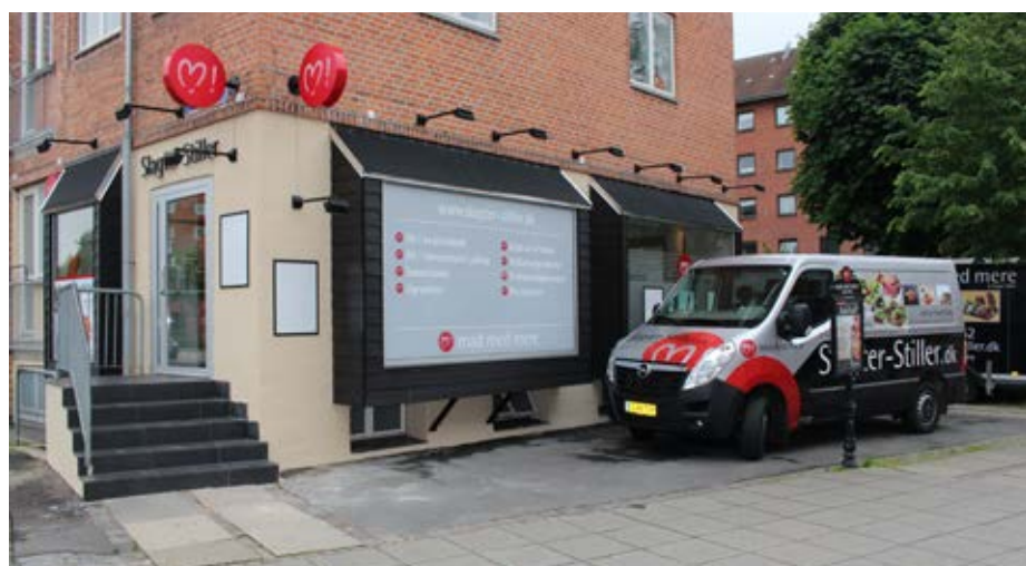
Det har givet mere plads, at forretningen har fået monteret tre karnapper af glas og træ.
