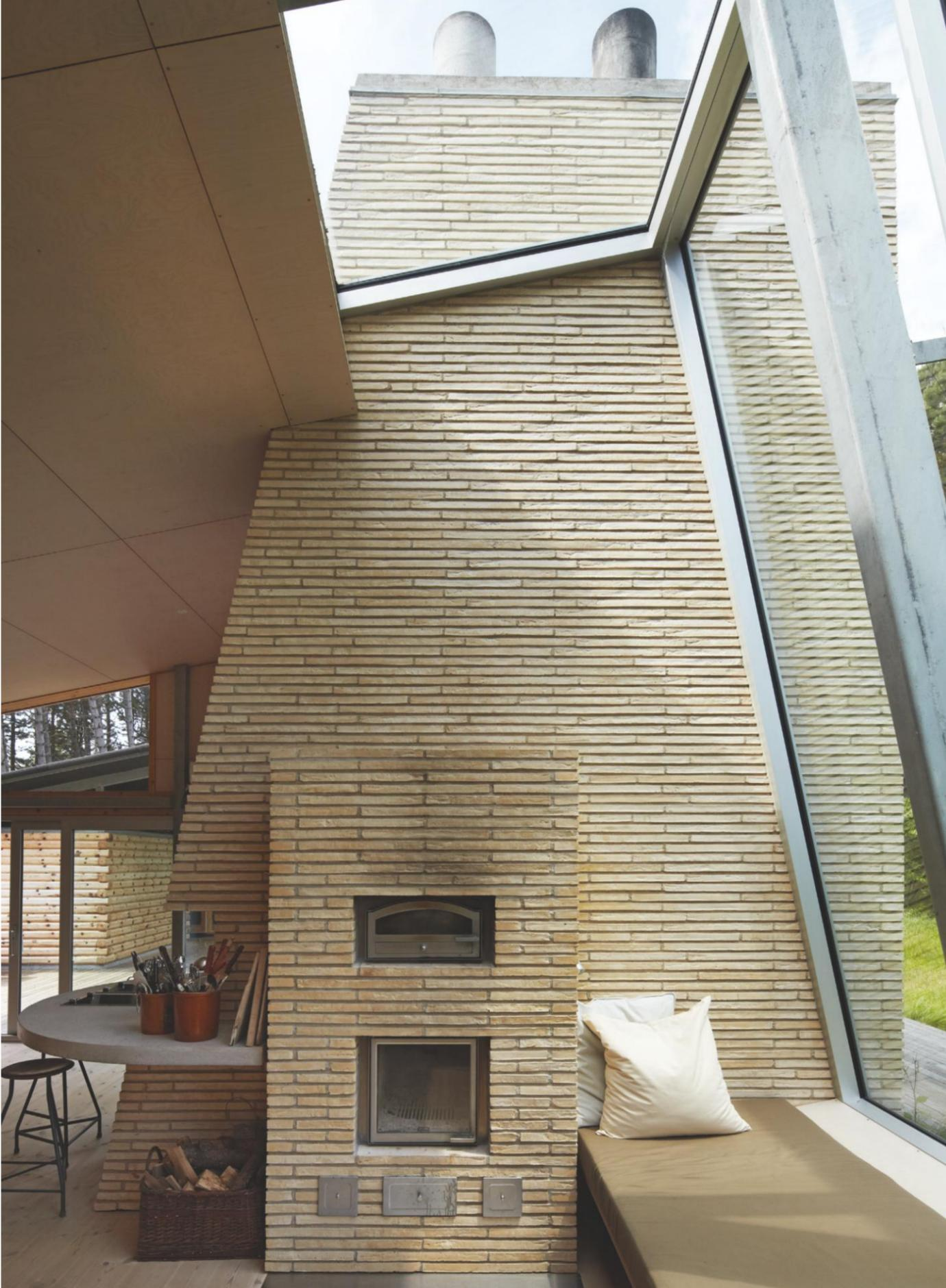
Der gemauerte Kern, Mittelpunkt des Hauses. Er enthält einen Masseofen, einen konventionellen Ofen und einen offenen Kamin.
