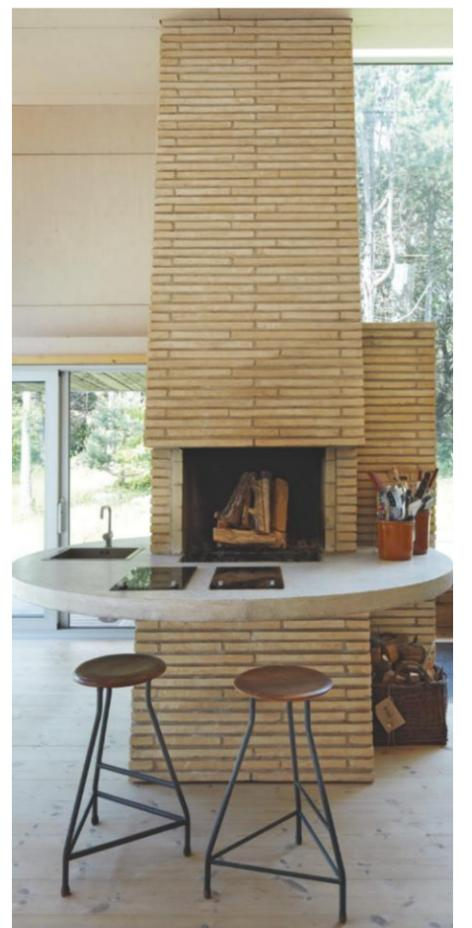
Der Mauerkern trägt eine Betonplatte, die als Esstisch dient.
