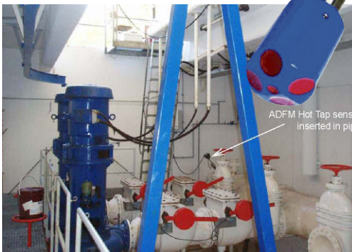
ADFAM Hot Tap pulserende dobbler flowmåler fra Teledyne ISCO giver en høj nøjagtighed og omkostningsbesparende flowovervågning på pumpestationer med begrænset straight-run
