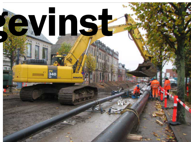
I Middelfart midtby fortsættes med afhjælpninger af driftsproblemer i kloaknettet, og i Middelfart gennemføres kloaksanering på bl.a. Odensevej, Ludvig Stormsvej, Ny Møllevej, Svinget og Brovejen. Der skal endvidere etableres en afskærende trykledning øst om Middelfart by sammen med en renovering af pumpestationen ved Vestre Hougvej
